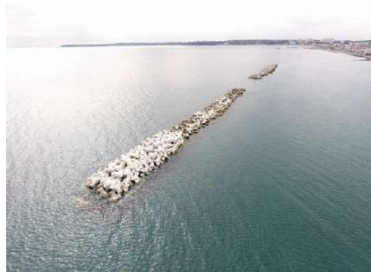
(2)離岸堤（北下浦漁港海岸）
