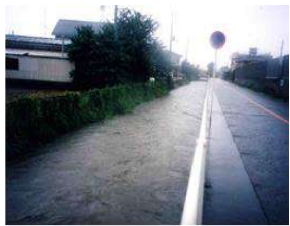
(2) 水路拡幅による周辺被害防止
