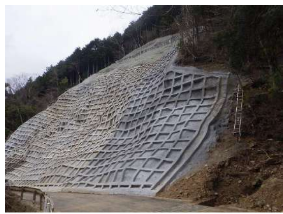
(2) 金沢林道 法面保護工 (清川村)
