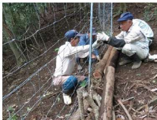
(2) 広域獣害防護柵の補修
