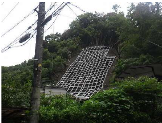
(1) 山腹工施工地 (横須賀市)
