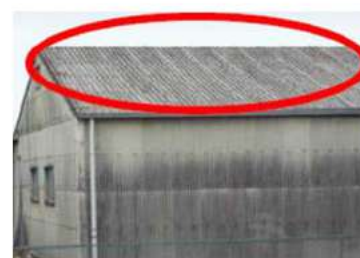
レベル3の石綿含有建材 （スレート）
