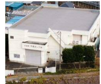
平塚揚水ポンプ所
