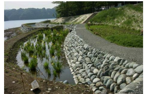
三井地区植物浄化施設
