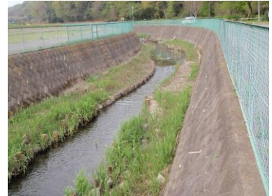
生態系に配慮した河川の整備(厚木市)
