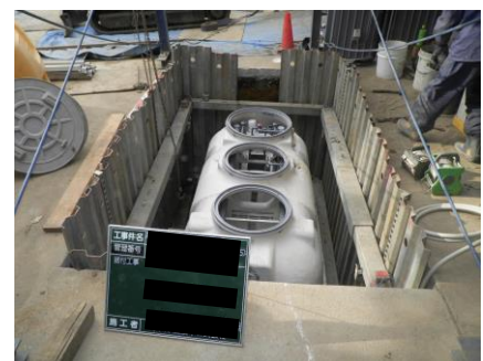
一般家庭への浄化槽設置(相模原市)
