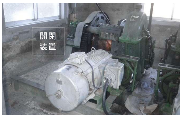
参一写真 5 開閉装置の現状
