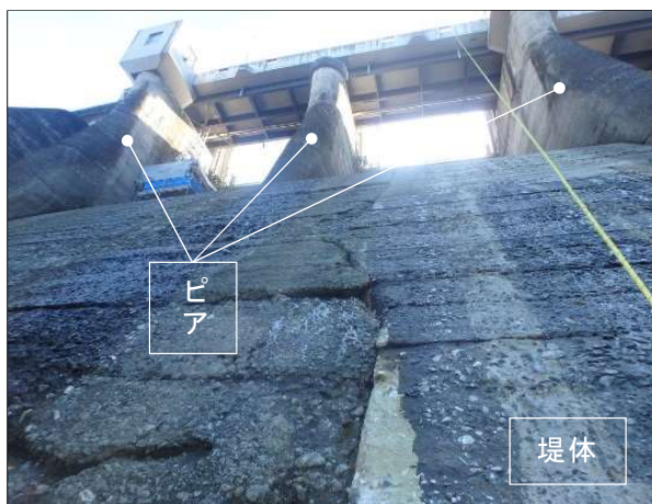
参一写真 3 堤体下流面（背面）の現状
