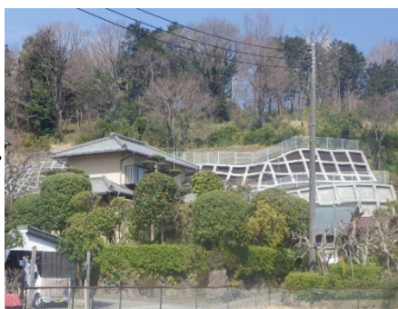
整備後の状況
