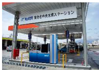
（固定式水素ステーション）
