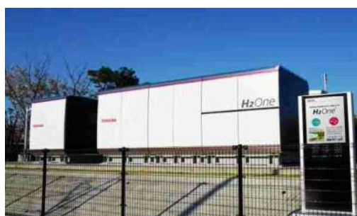
再生可能エネルギーと水素を用いた 自立型エネルギー供給システム「H 2 One」 (川崎マリエン)
