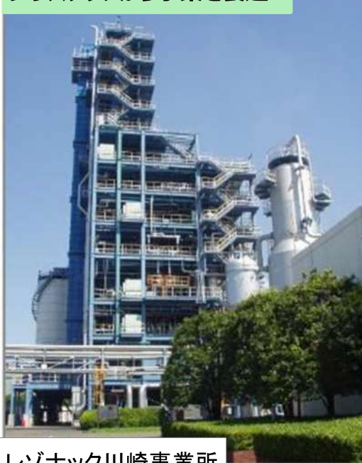
レゾナック川崎事業所 （ガス化プラント）
