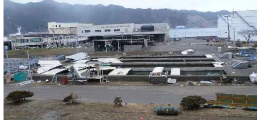
下水処理場の水処理施設の被害状況 (宮城県釜石市 大平下水処理場)
