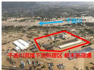
下水処理場の被害状況
