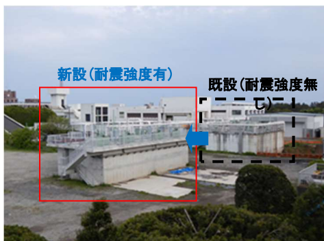
分水槽の耐震対策
