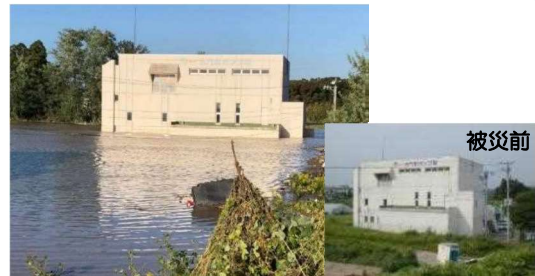
ポンプ場の被害状況
