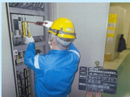
図 電気設備の点検状況
