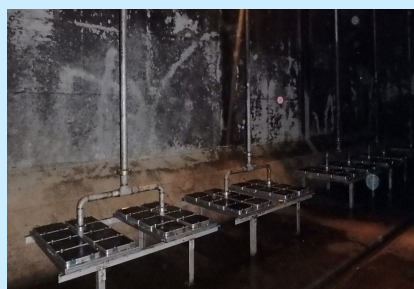
図 散気装置の改築（扇町水再生センター）
