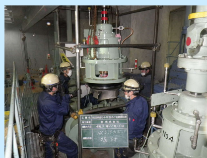
図 機械設備の修繕状況
