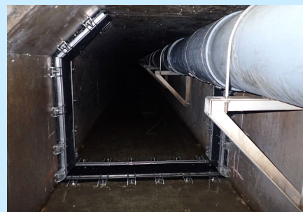
図 耐震対策例（四之宮水再生センター）
