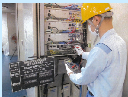
図 電気設備の点検状況
