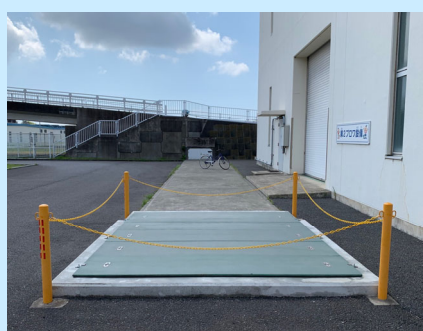
図 耐水化工事（開口部嵩上げ）
