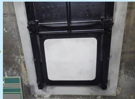
図 老朽化した機械設備の改築例（柳島水再生センター）
