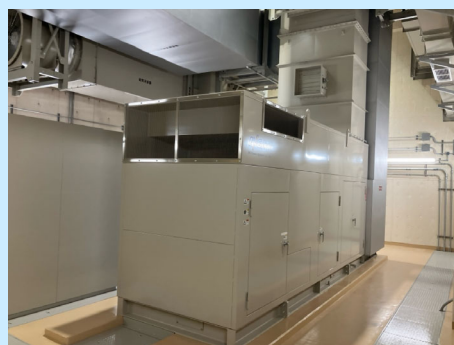
図 老朽化した自家発電設備の改築例（四之宮水再生センター）
