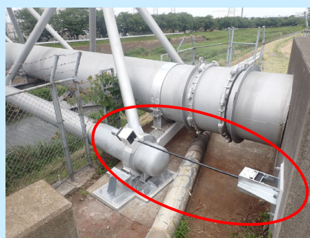
図 管きよの耐震工事例（水管橋）
