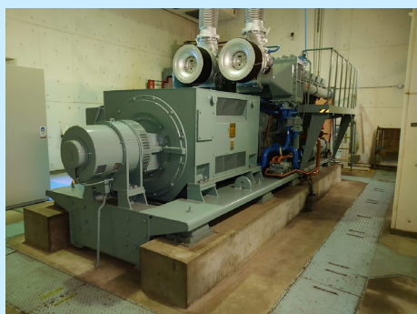
図 老朽化した自家発電設備の改築例（四之宮水再生センター）
