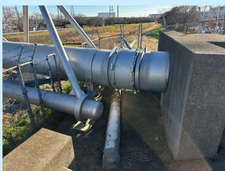
図 管きよの耐震工事例（水管橋）
