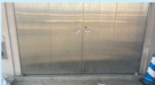
図 耐水化工事例（東豊田ポンプ場）
