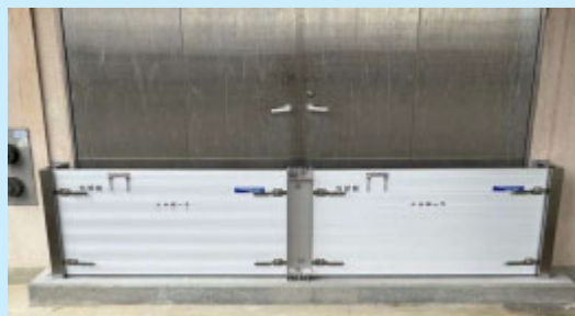
図 耐水化工事例（東豊田ポンプ場）
