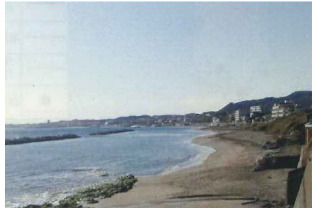
野比海岸（侵食対策の離岸堤）
