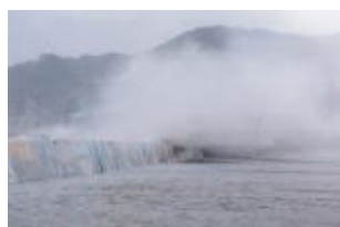
平成7年 台風12号による越波
