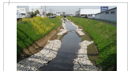
⑥河川・水路における自然浄化対策 自然石による護岸とし、生物の生息空間を確保した。(厚木市恩智川)
