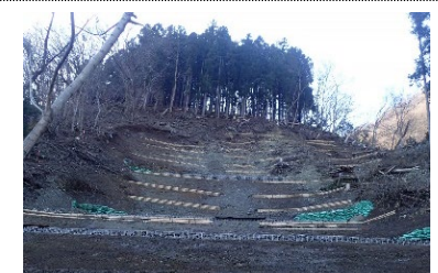
③土壌保全対策 水源林の基盤整備では土木的工法を用いて土壌保全対策を実施した。(山北町世附)
