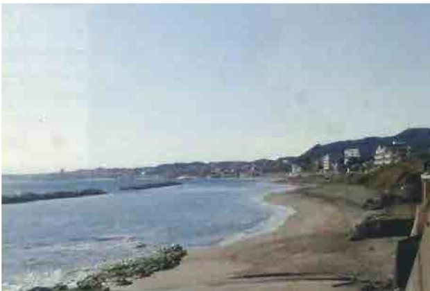
野比海岸（侵食対策の離岸堤）
