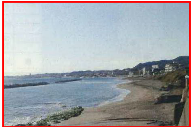
野比海岸（侵食対策の離岸堤）
