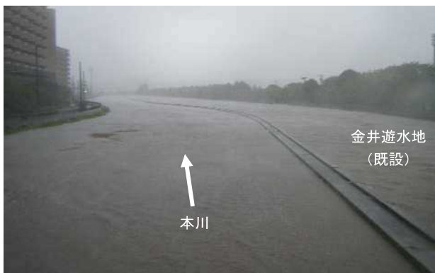
平成 26 年台風第 18 号における出水状況 (柏尾川)
