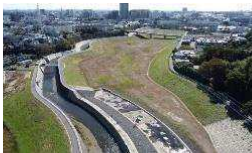
引地川下土棚遊水地（R 2 本体完成）
