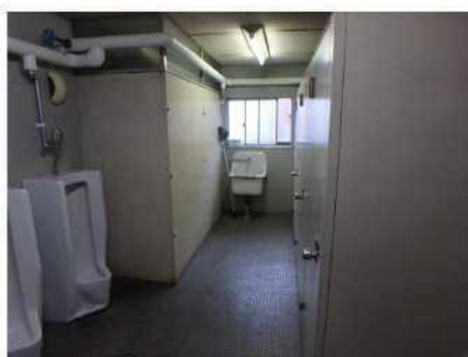
改修工事前（例）
