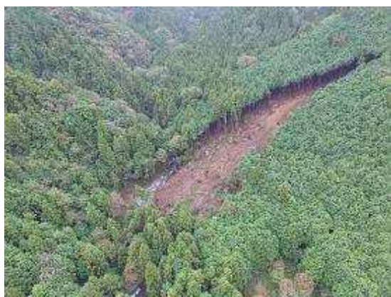
ドローンを使用した上空からの空撮による崩落現場の確認
