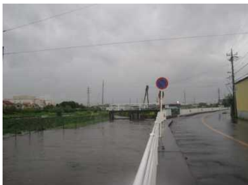
農業用排水路の溢水状況 (令和元年台風第19号)
