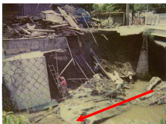
平成2年の洗掘被害（塩海橋下流）
