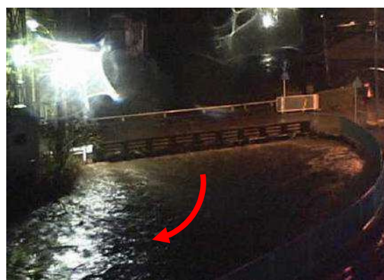
平成25年の浸水状況（内輪橋）
