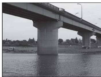
橋りよりの耐震化（相模川 座架依橋）
