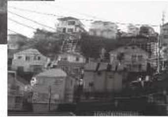
急傾斜地における宅地開発状況 (土砂災害警戒区域等の見直しが必要となる)
