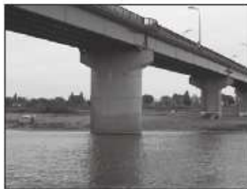
橋りょうの新築化（相模川 龍崎水橋）
