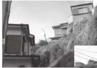
がけ高 10m 未満の未整備斜面状況 (公共探検基準の緩和が求められる)
