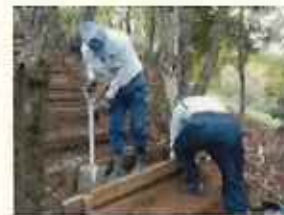
発生材を活用した小破修繕
