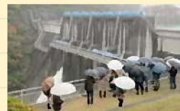
水道フレンズ交流会 城山ダム見学の様子
