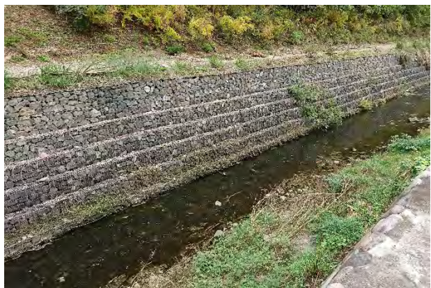
護岸に多孔質材を使用 注
