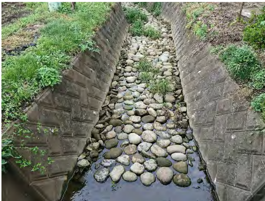
河床に礫を敷く
