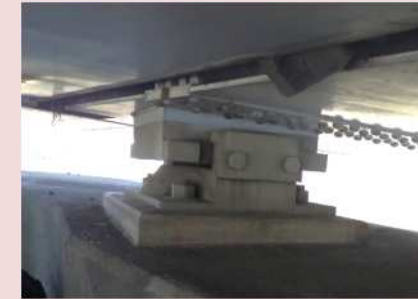
施工前の状況 (P1 支承)
