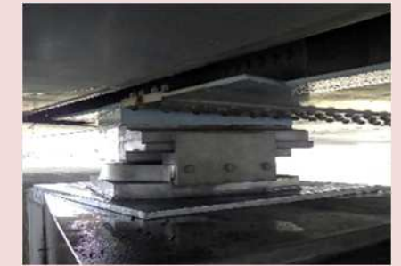
施工後の状況 (P1 支承)
