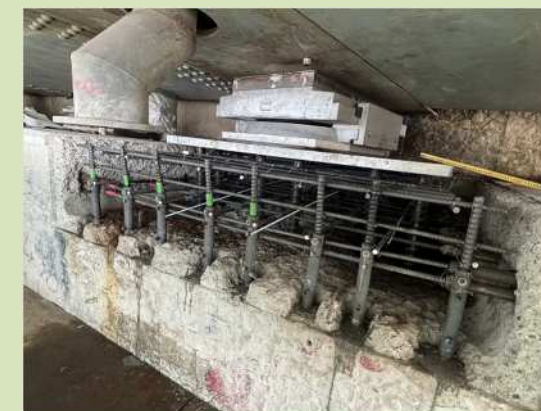
施工状況 (A1 橋台)
