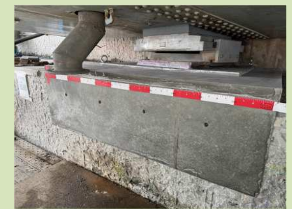
施工状況 (A1 橋台)
