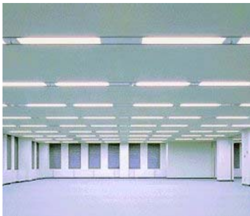
「ワイヤー吊りグリッド天井」の概念図
