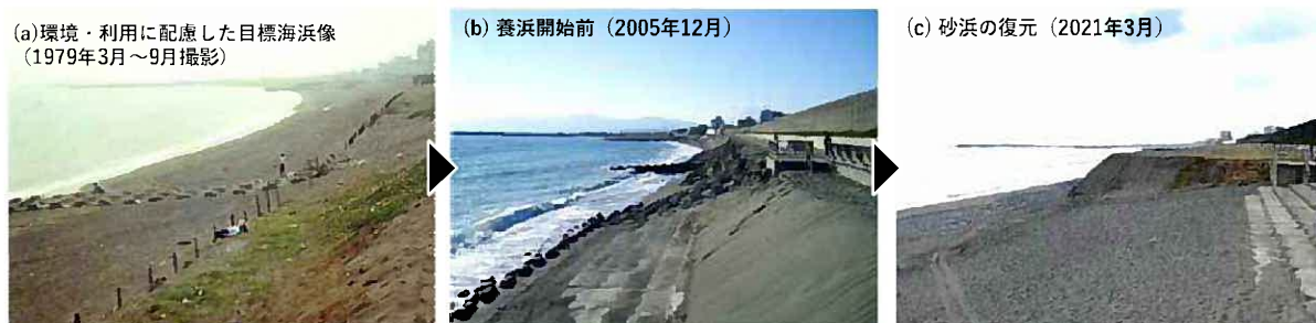
図6.1 環境・利用に配慮した目標海浜像と養浜開始前と現在の砂浜
