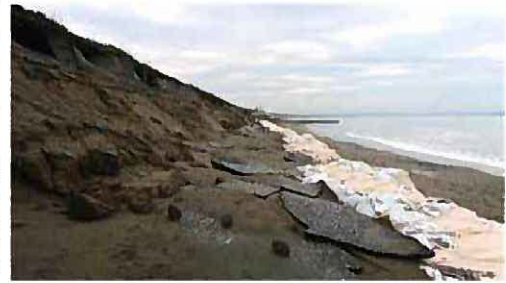
図3.37 T1919来襲時の高波浪による自転車道の崩壊
