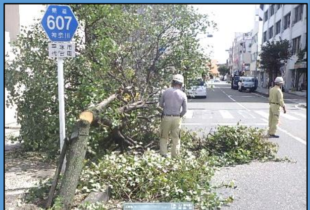
台風により倒れた街路樹を撤去
