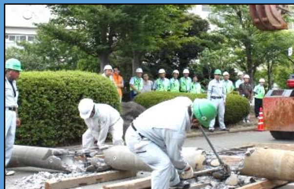
電柱は人力で小分けにして撤去
