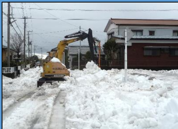
積もった雪の撤去作業
