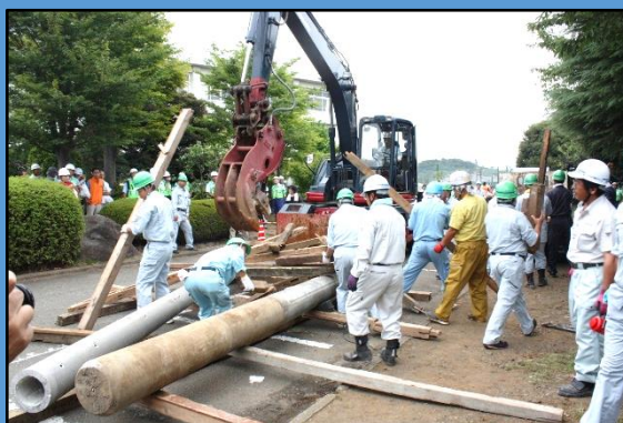
地震被害を想定した障害物の撤去
