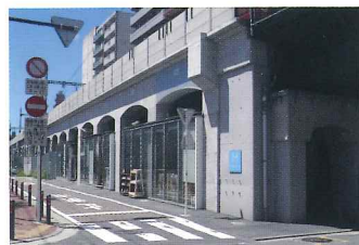
高架下目ノ出スタジオ（桜橋付近）
