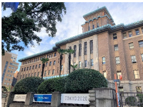
(本庁舎ドレッシングの様子)
