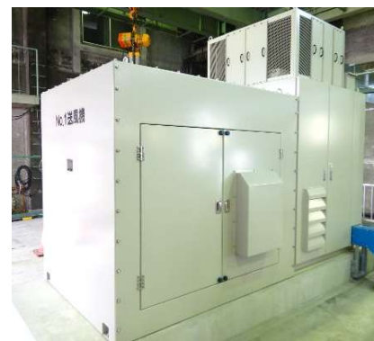
送風機の改築更新（酒匂川流域下水道左岸処理場）
