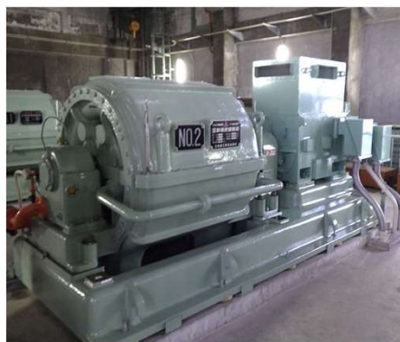
送風機の改築更新（酒匂川流域下水道左岸処理場）
