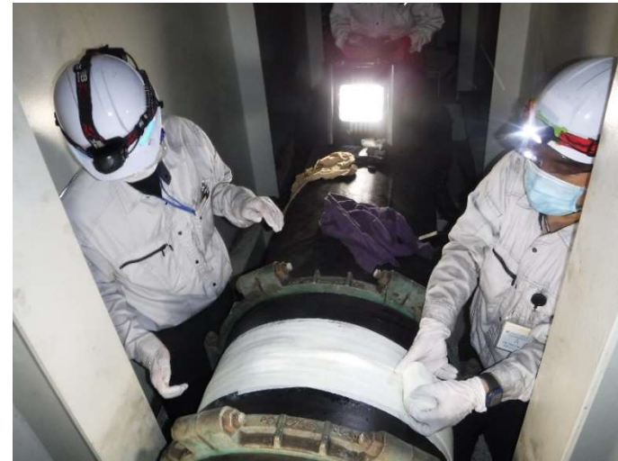
老朽化した管渠を修繕している様子
