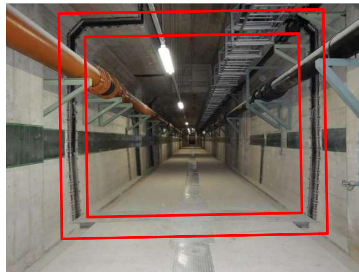
地下通路を補強する耐震工事 (相模川流域下水道右岸処理場)
