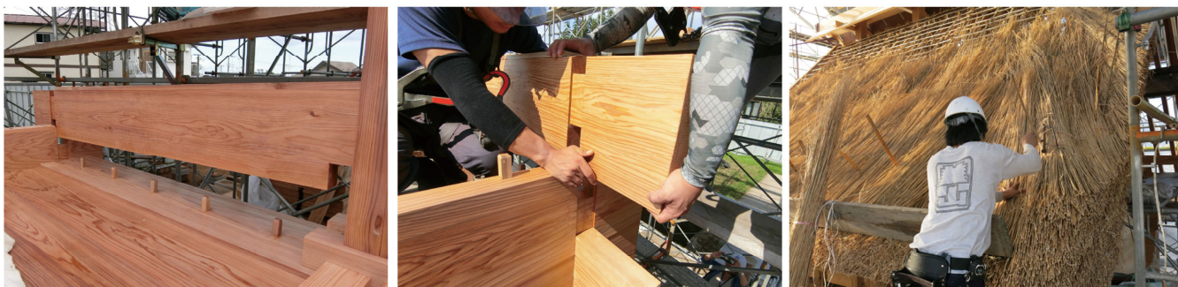
写真1・2 板校倉組立て状況
