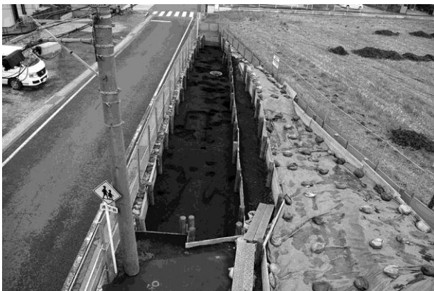
写真1 平安時代遺構全景 (北西から)
