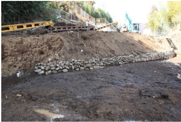
K 6 号石垣検出 (南)
