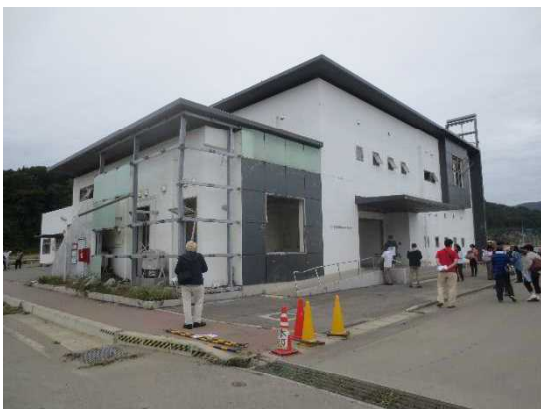
岩手県釜石市 鵜住居地区防災センター →解体
