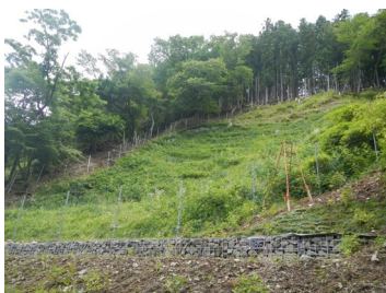
水源林の基盤整備
