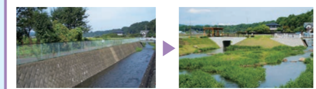
▲整備前 ▲整備後 コンクリートブロックによる護岸整備 瀬や淵ができたことで、自然浄化機能が向上
