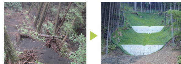
▲スコリア(富士山の火山噴出物)堆積層の流出 ▲土木的工法による取組例(土留め工)
