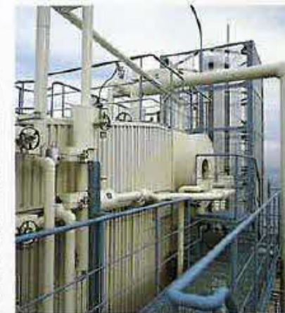
■廃熱ボイラー 焼却時に発生する廃熱から蒸気回収を行い、エネルギーを有効に活用します。
