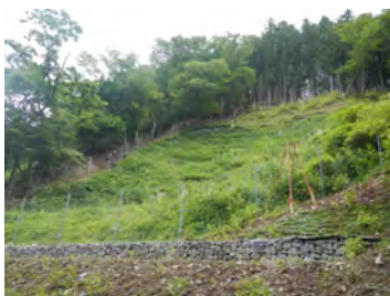
水源林の基盤整備
