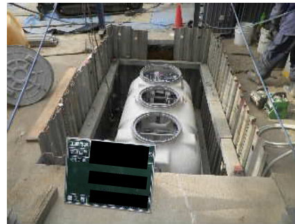
(一般家庭への浄化槽設置(相模原市))
