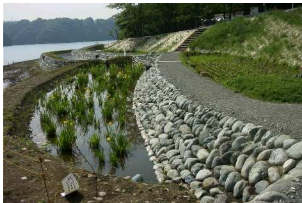
(三井地区植物浄化施設)
