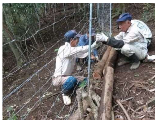
(2) 広域獣害防護柵の補修
