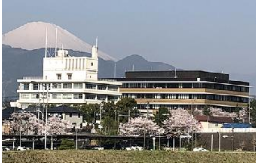
(左) 旧足柄上合同庁舎 (右) 新足柄上合同庁舎 (平成 30 年 3 月)
