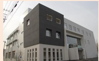
開催当日は外壁工事中
