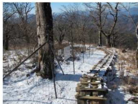
高標高域自然林土壤保全対策事業 で設置された植生保護柵 (相模原市・山北町(犬越路))
