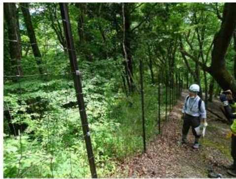
植生保護柵点検（ヌタノ沢）
