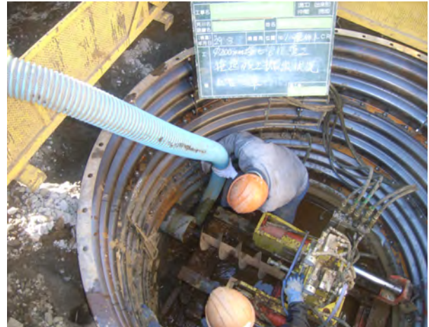
公共下水道の整備（相模原市）
