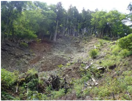
水源林の基盤整備
