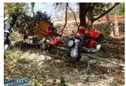
拠点より斜面をつたって資材を運搬
