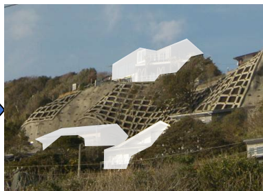
整備直後の状況
