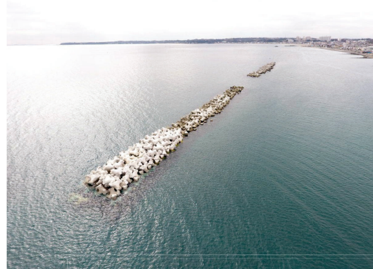
離岸堤（北下浦漁港海岸）
