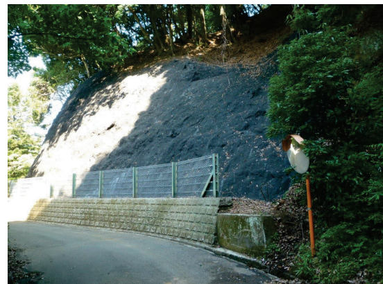
薬師林道 法面保護工（伊勢原市）
