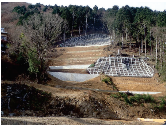
山腹工施工地（箱根町）
