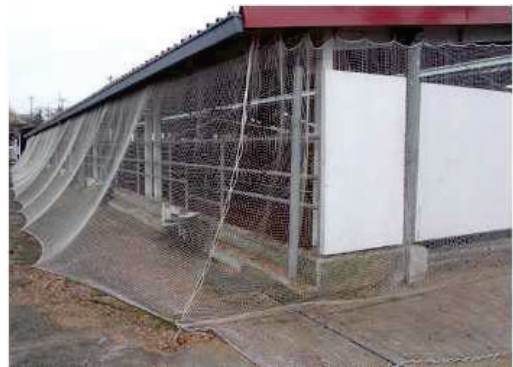
防鳥ネットの補修
