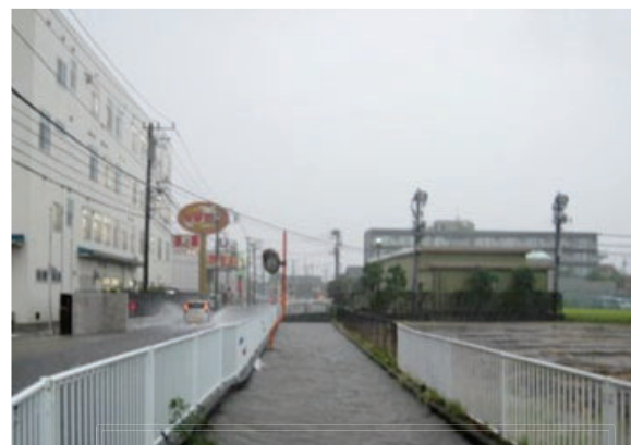
水路拡幅による周辺被害防止
