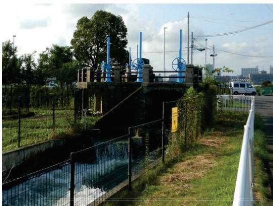
水門の遠隔電動操作化
