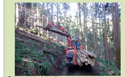
④間伐材搬出促進 間伐材の有効活用により森林整備を促進し、公益的機能の高い、良好な森林づくりを進めた。（相模原市鳥屋）
