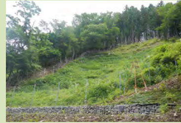
③土壌保全対策 水源林の基盤整備では土木的工法を用いて土壌保全対策を実施した。（山北町世附）
