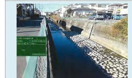
⑥河川・水路における自然浄化対策 自然石を河床に設置し、生物の生息空間を確保した。（厚木市干無川）
