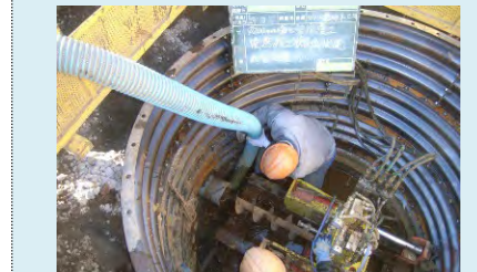
⑧生活排水処理施設の整備促進（下水道・浄化槽） 道路を開削せず、トンネル状に掘削した穴に管を通す工法により下水道管を敷設した。（相模原市緑区）
