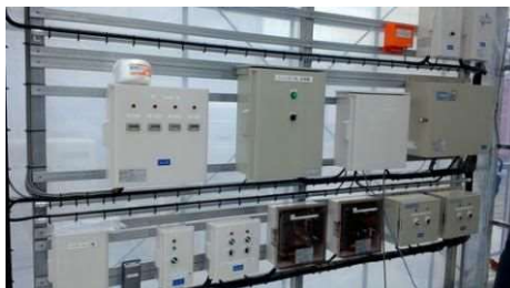
施設栽培における環境制御装置
